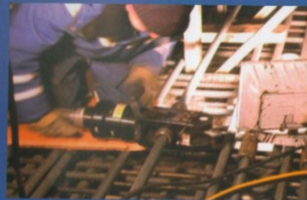
Опрессованные соединения арматуры в фундаментной плите
