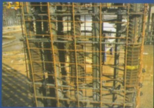
Опрессованные соединения арматуры в колонне
